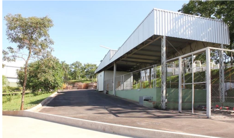
Figura 12 – Estação de tratamento de efluentes.
