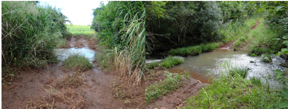
Figura 6 : Acesso de estrada que cruza o Lajeado Pratos.
