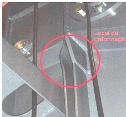
De forma a analisar a área deformada fez-se necessário isolar a seção de estudo do restante da estrutura. Após isolar os conjuntos realizou-se a análise estática do equipamento na condição de maior esforço, isto é, durante o movimento de elevação do silo, que, em situação de trabalho, forma ângulo reto com o solo. A Figura 5 mostra o caminho percorrido pela central para levar o silo da posição de transporte para a posição de trabalho. Figura 5. Mudança de posição da central móvel de concreto.
